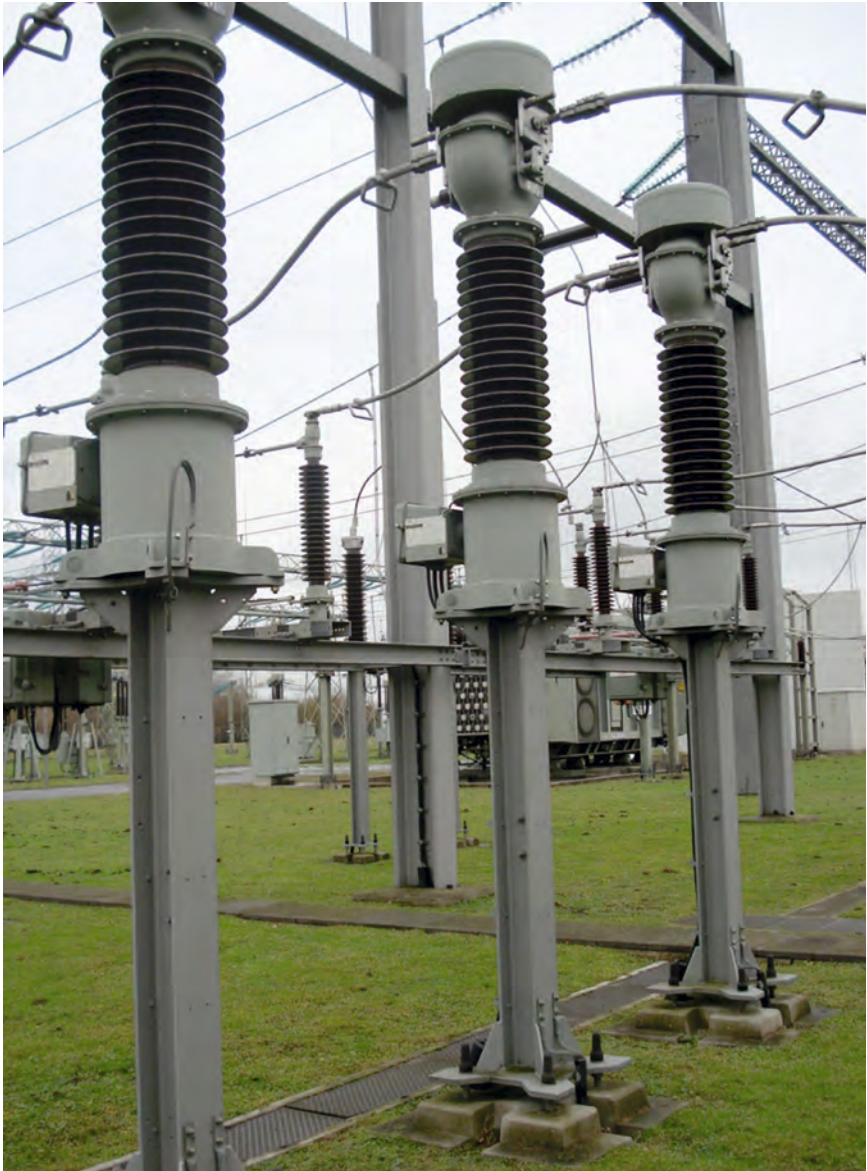
Abb. A.1: Beispiel für eine 110-kV-Freiluftschaltanlage. Foto: Wölfel Beratende Ingenieure GmbH + Co. KG
