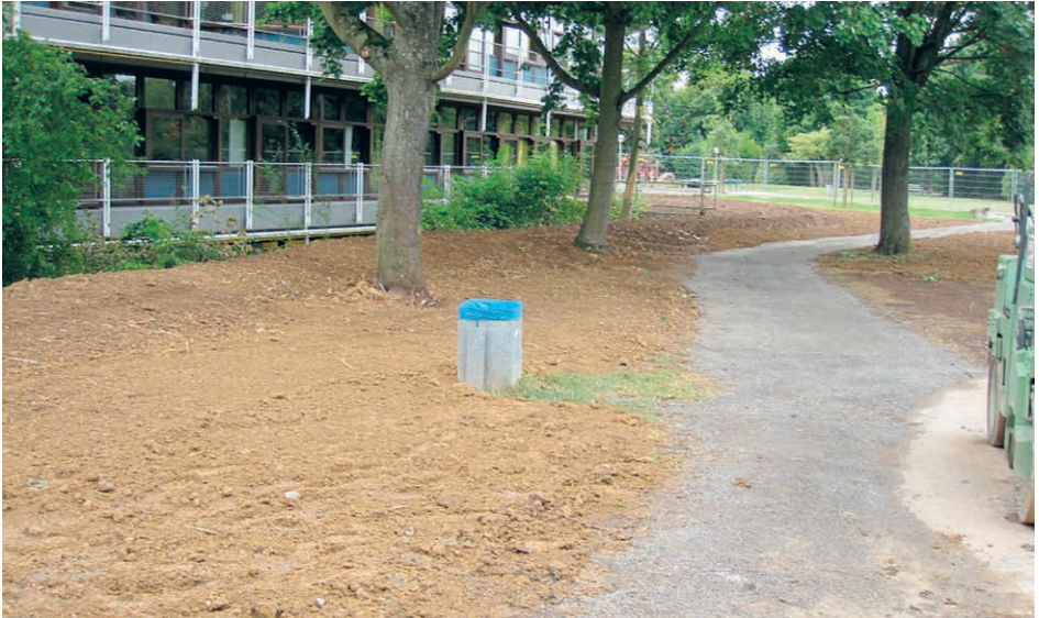
Abb. 108: Bau eines Schutzwalls gegen das Hochwasser der Glems am Gymnasium in Ditzingen (Objektschutz)
