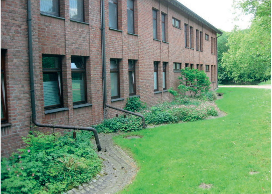
Abb. 75: Ob Alt- oder Neubau: Offene Regenwasserableitungen und Mulden können fast immer gebaut werden.
