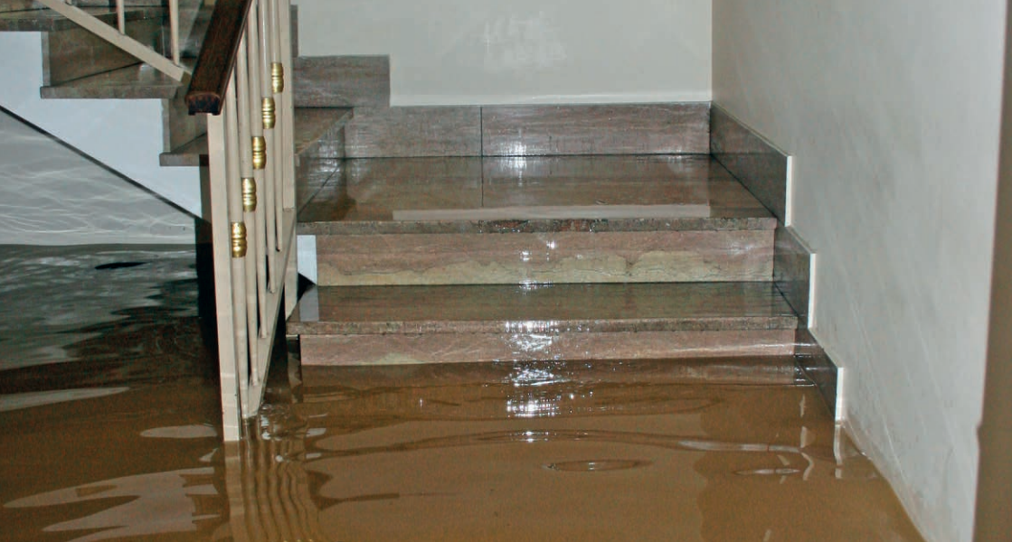
Abb. 16: Überfluteter Keller nach Starkregen
