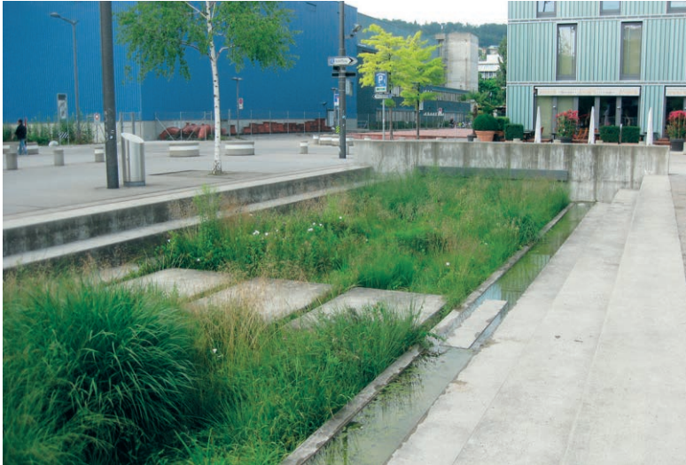
Abb. 76: Selbst kleine Grünstreifen und Senken in Industrie- gebieten kön- nen größeren Schäden bei einem Starkregen verbeugen.
