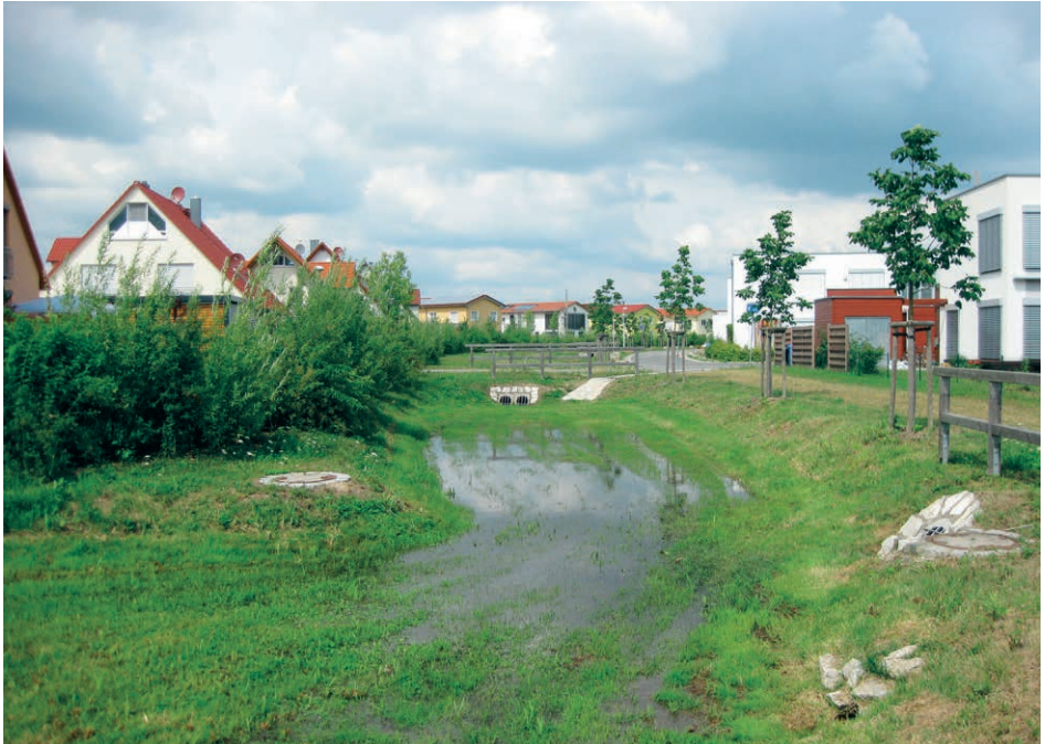
Abb. 70: Überflutungsmulde in Erlangen in einem Wohngebiet
