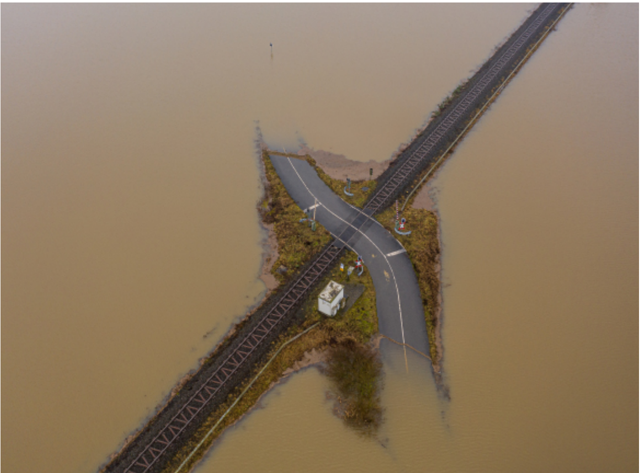
Abb. 4: Überflutete Verkehrswege infolge der Extremniederschläge in Westdeutschland im Juli 2021 (Quelle: Shutterstock/bear productions)
