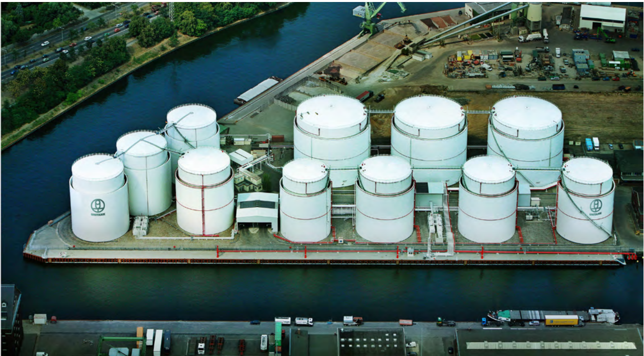
Abbildung 3 Tanklager Westhafen Berlin (Quelle: UNITANK).
