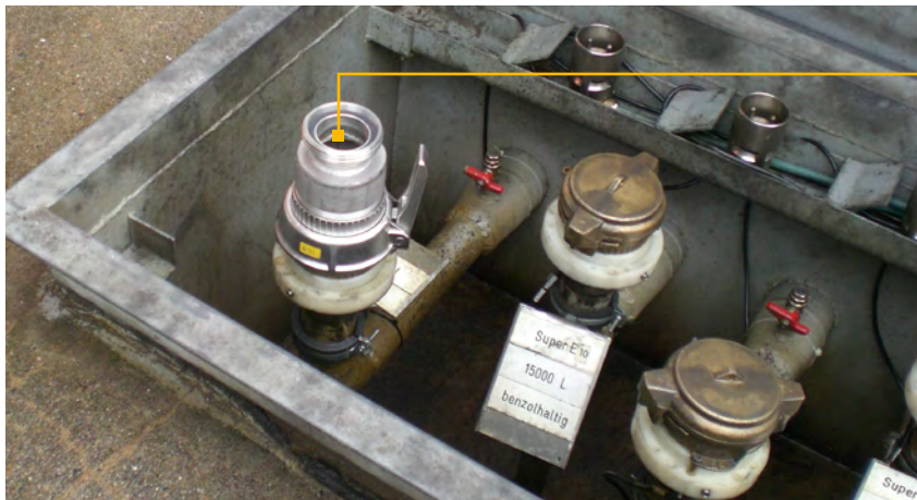
Abbildung 21 Übergangsstück TW/DN50 Schraubgewinde (Quelle: M. Tessin).
