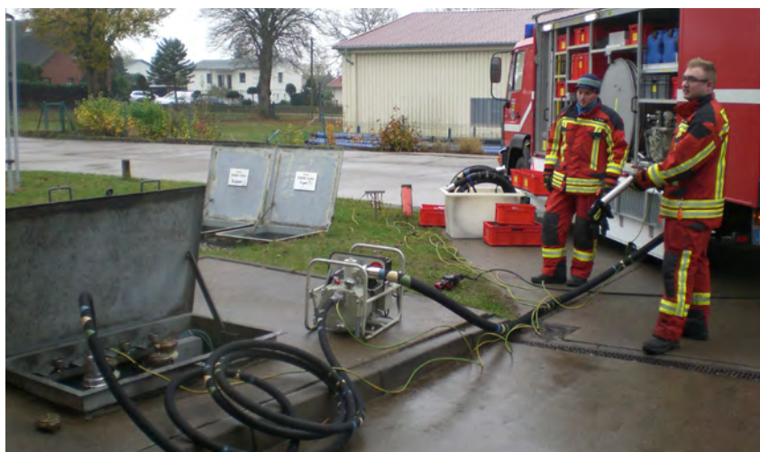
Abbildung 24 Erdung der Anlage (Quelle: M. Tessin).
