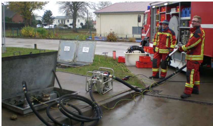
Abbildung 24 Erdung der Anlage (Quelle: M. Tessin).
