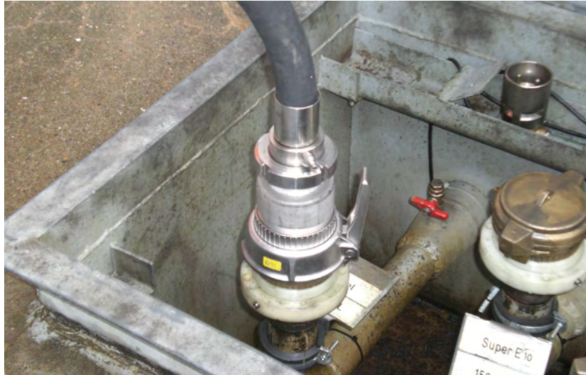
Abbildung 22 Anschluss Chemikalienschlauch (Quelle: M. Tessin).
