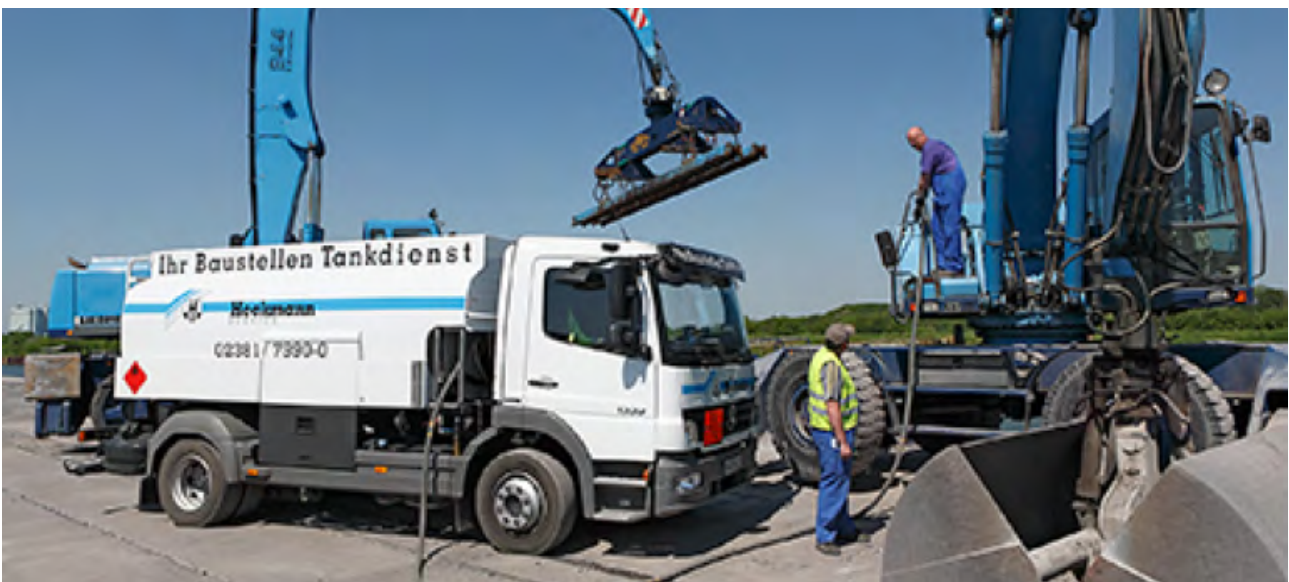
Abbildung 5 Tankwagen zur Versorgung von Notstromaggregaten (Quelle: Heckmann Service GmbH & Co. KG). 28
