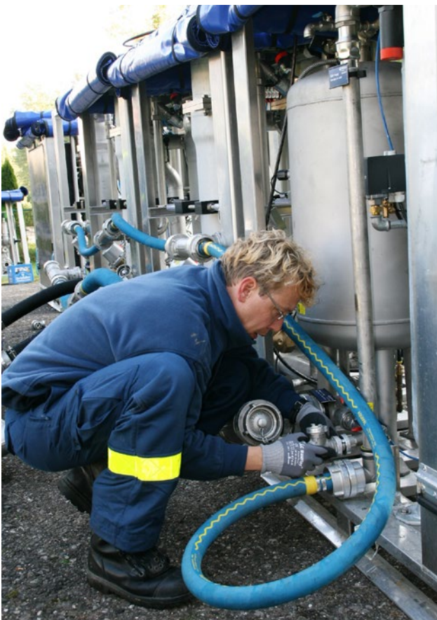
Abbildung 5: Fachgruppe Trinkwasser betreibt Trinkwasseraufbereitungsanlage UF-15 (Bildquelle: THW)
