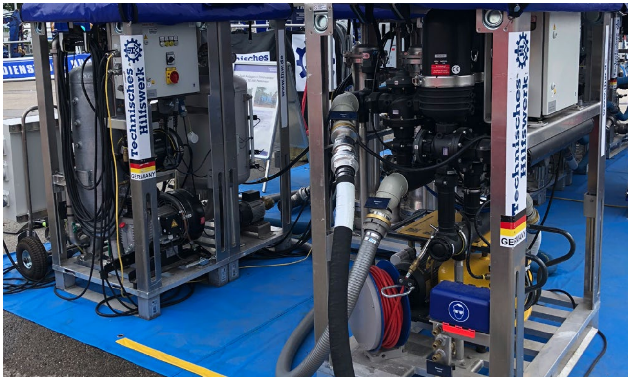
Abbildung 20: UF-15 Anlage des THW (Bildquelle: SWA)
