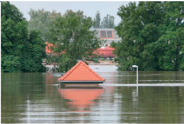
Flutung eines Gebäudes zur Probenahme an den Fassungsanlagen im Jahr 2013, Dresden © DREWAG
