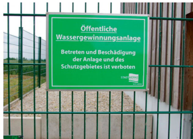
Hinweise zur Sicherheit an Wasserversorgungsanlagen © Stadtwerke Bad Salzuffen
