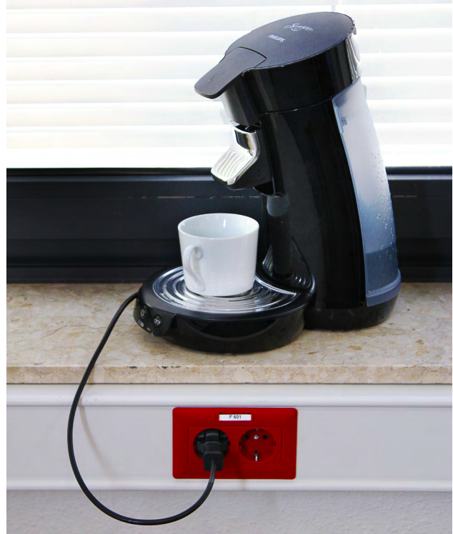
Durch nicht notstromberechtigte Verbraucher an Notstrom-Steckdosen, in unserem Beispiel eine rote Steckdose, droht eine Überlastung der Notstromanlage; Quelle: BBK
