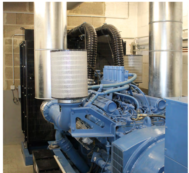
Netzersatzanlage; Quelle: BBK
