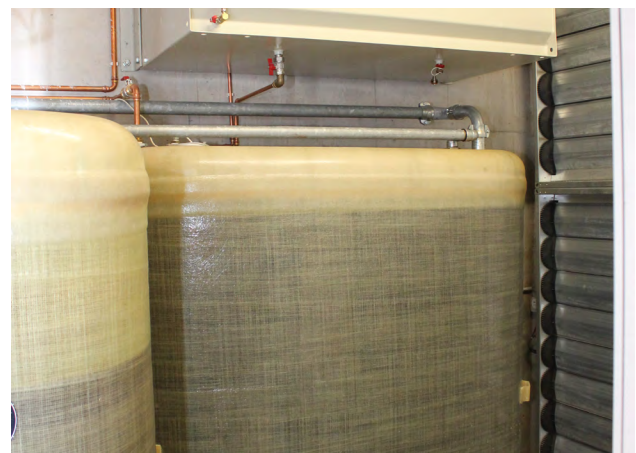
Haupt- und Tagestank einer Netzersatzanlage; Quelle: BBK
