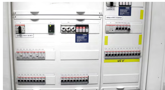
Etageverteilung mit notstromversorgten Stromkreisen; Quelle: BBK
