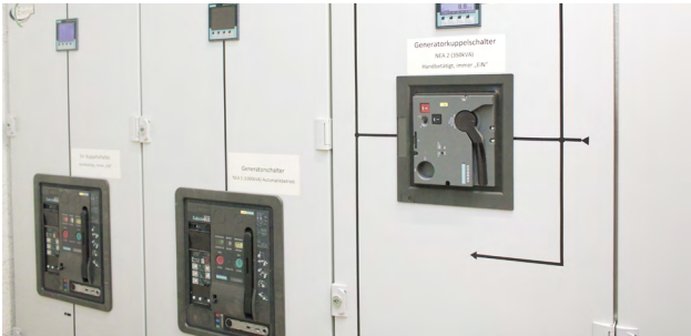
Schaltanlage einer modular aufgebauten Netzersatzanlage; Quelle: BBK
