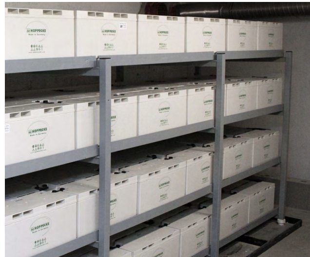
Batterieanlage für eine unterbrechungsfreie Stromversorgungsanlage; Quelle: BBK
