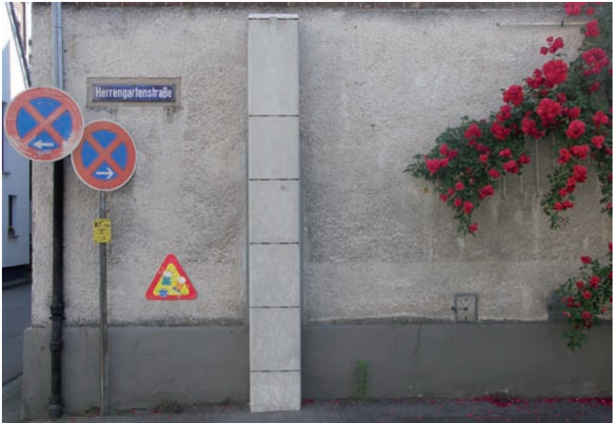
Abbildung 3.2: Beispiel zur Herabsetzung der Funktionsanfälligkeit: Zu Hochwasserschutz Zwecken erhöht angebrachter Kabelverteilerkasten. Auch wenn vereinfachend von einem Ausfall der Stromversorgung im Überschwemmungsgebiet ausgegangen werden kann, so gibt es Möglichkeiten den Funktionsausfall durch eine angepasste Bauweise zu verhindern. (Foto: Luttermann (UNU-EHS), 2009)
