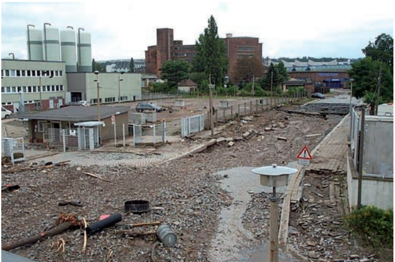
Abbildung 3.3 und 3.4: Ein Hochwasserereignis geht mit dem Abfließen des Wassers nicht spurlos vorüber - am Beispiel des Betriebs hofs des Kraftwerks Nossener Brücke in Dresden wird deutlich, was das Wasser zurücklässt. (Bildquelle: Maschinen- und Stahlbau Dresden, August 2002)
