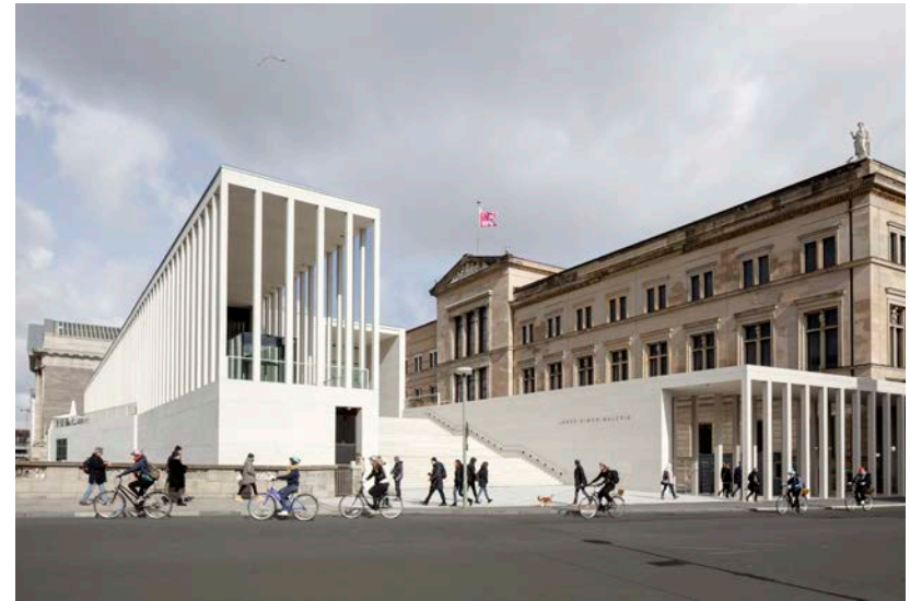
James-Simon-Galerie, Ansicht des Haupteingangs © Ute Zscharnt für/for David Chipperfield Architects
