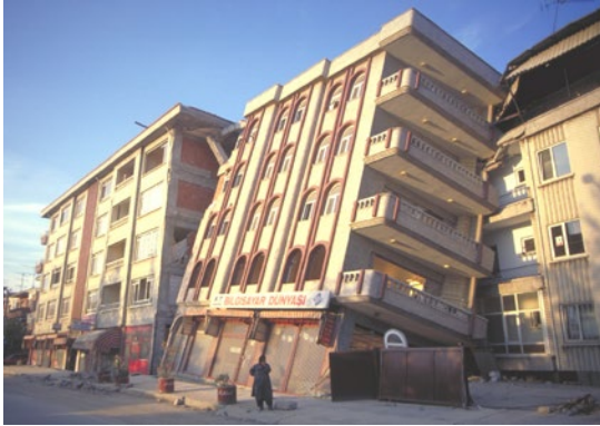
Abb. 6a und 6b: Bodenverflüssigung, Izmit 1999. Fotos: P. Lestuzzi, SGEB-Erkundungsmission
