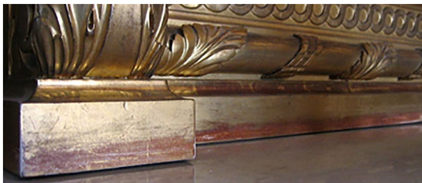
Abb. 1: Durch feuchtes Abwischen des Marmorsimses wurde die Blattvergoldung des Spiegelrahmens abgetragen. Foto: Christoph Wenzel
