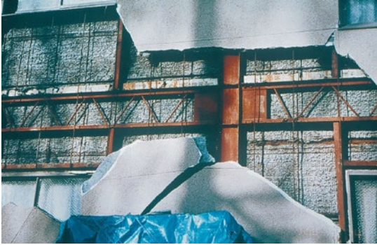
Abb. 4a und 4b: Heruntergefallene Fassadenelemente, Kobe 1995. Foto 4a: Architectural Institute of Japan, Foto 4b: T. Wenk, SGEB-Erkundungsmission
