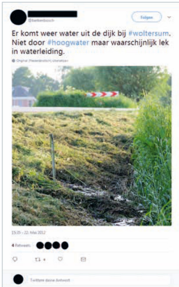
Abbildung 23 Tweet: „Es tritt wieder vermehrt Wasser aus dem Deich bei #woltersum. Nicht durch #hoogwater bedingt, sondern wahrscheinlich durch ein Leck in einer Wasserleitung.“ (Berkenbosch, 2012)
