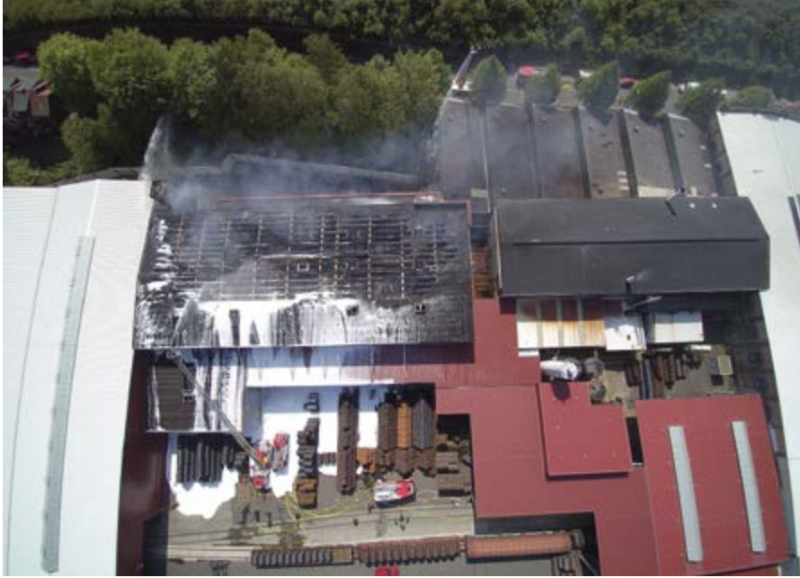
Drohneinsatz an einer einsturzgefährdeten Halle.
