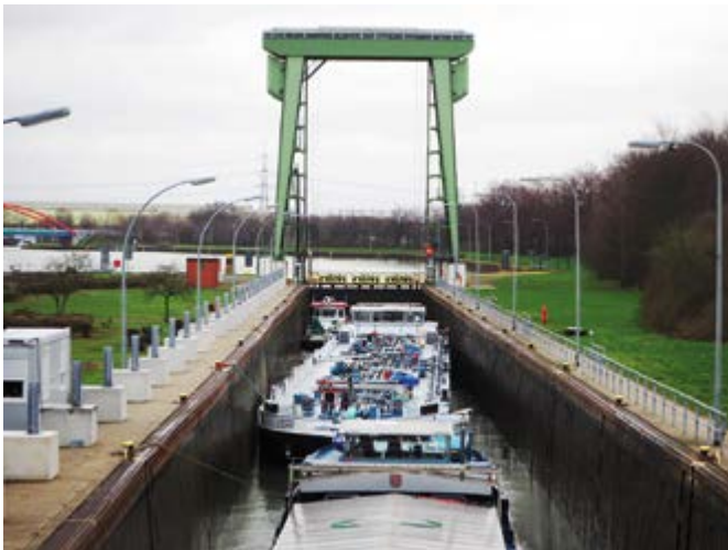
Abbildung 4: Schleuse Friedrichsfeld – defekte Poller in der Kammerwand bedingen einen manuellen Festmacherdienst mit erheblicher Verzögerung der Schleusungszeiten (Foto: Weiler)
