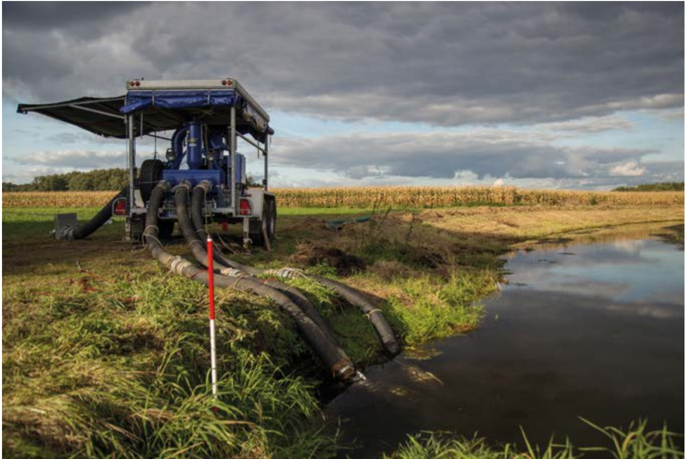
Pro Minute pumpen THW-Kräfte bis zu 20.000 Liter Wasser, das über drei Wasserförderstrecken zum Einsatzort gelangte. (Foto: Yann Walsdorf / THW)
