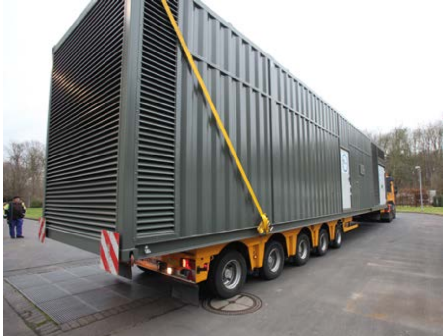
Lieferung eines Notstromaggregates für ein Wasserversorgungsunternehmen. (Foto: Rheinenergie AG)
