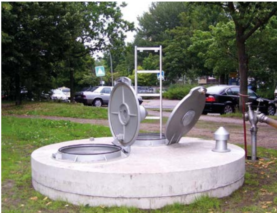
Ein auf der Rechtsgrundlage des Wassersicherstellungsgesetzes (WasSiG) neu errichteter Trinkwassernotbrunnen in Hamburg. (Bild: BBK)
