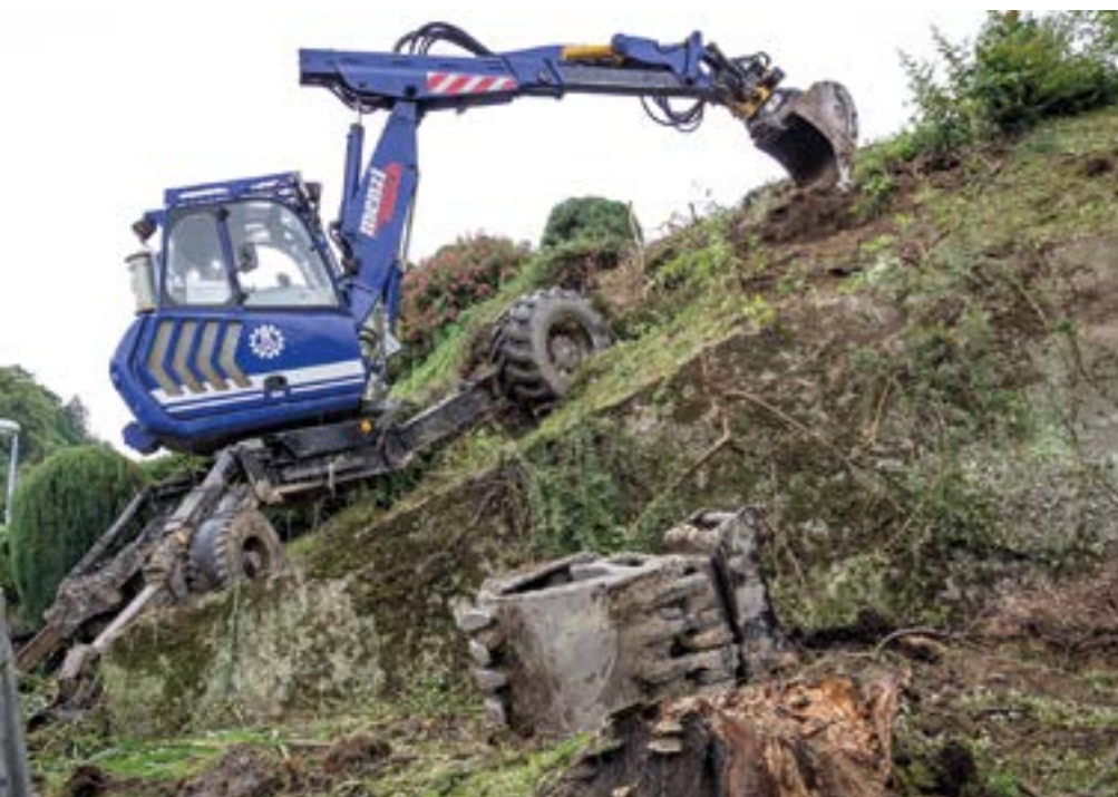
Bereits während der Starkregenfälle 2016 setzte das THW die Prototypen der Einsatzrettungsspinne testweise zur Hangsicherung in Bayern ein. (Foto: THW / Michael Matthes)
