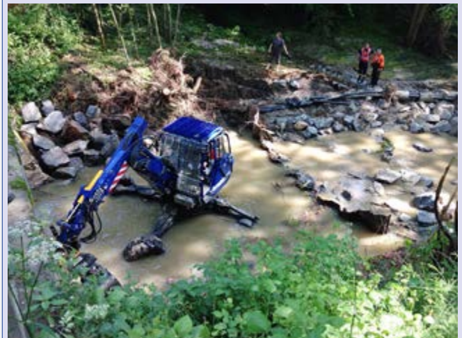
Arbeiten, wo andere Mittel aufgeben. Wat-Tiefe bis 1,80m.
