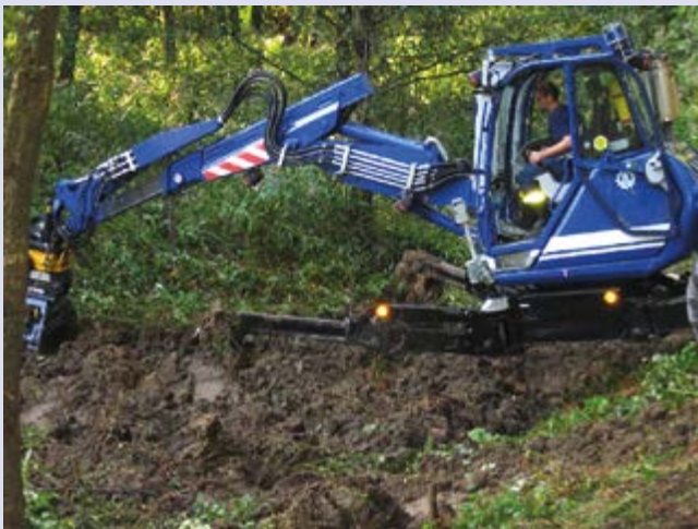
Bewegung über abgetragenes Erdreich ohne großflächige Berührung des Untergrundes.
