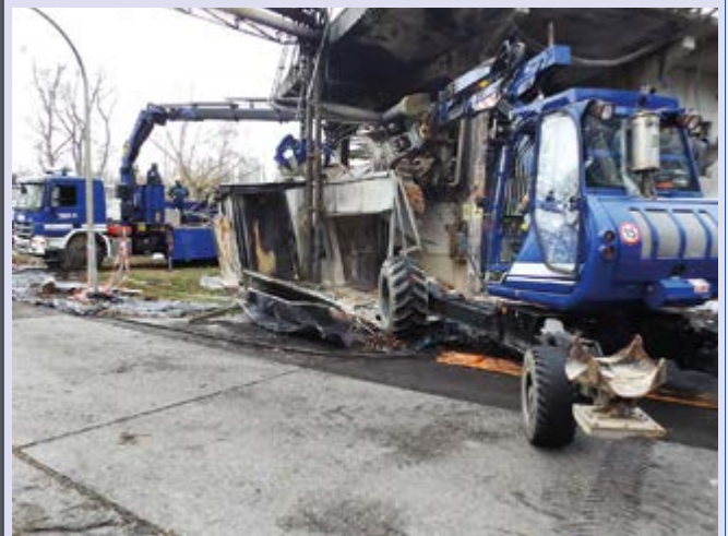
Die Beweglichkeit des Tiltrotators lässt feinfühlig und exakte Anpassungen an die Situation zu und macht Arbeiten an labilen Objekten einfach.
