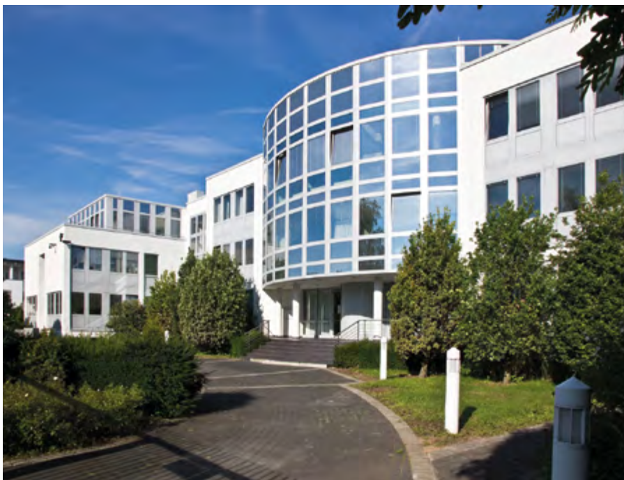
Das neue Kommando Cyber- und Informationsraum in Bonn (Foto: Pump / Bundeswehr)
