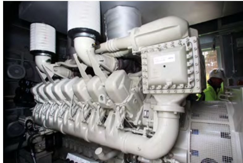
Abb.: 3: Notstromversorgung eines Wasserversorgungsunternehmens. (Quelle: Rheinenergie Köln)
