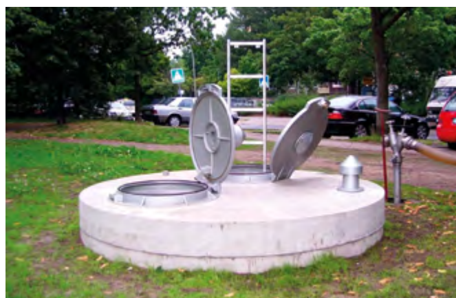
Wasserförderung mit Unterwassermotorpumpe. (Foto: Kutter)
