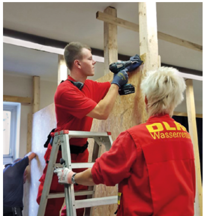
Bau von Zwischenwänden. (Fotos: DLRG)
