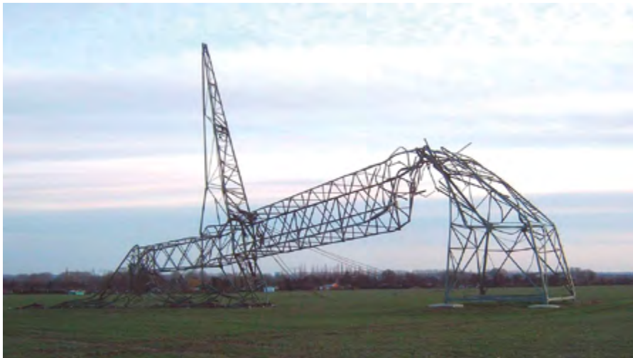
Während des Orkantiefs Kyrill (2007) umgeknickter Strommast bei Magdeburg-Otterleben. (Foto: Olaf2/Wikimedia Commons)
