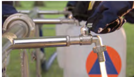
Zapfstelle Trinkwassernotbrunnen. (Foto:BBK)
