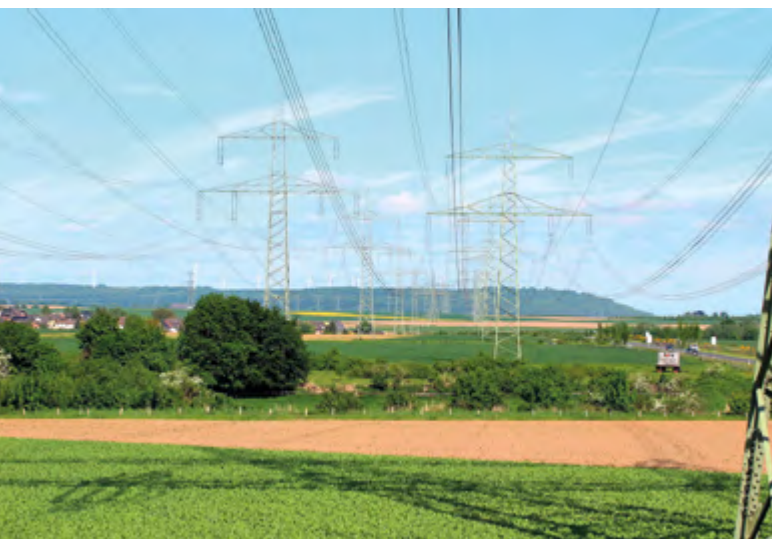
Mit Hilfe beschriebener Schäden an Strom- und Fernmeldeversorgungsanlagen aus vergangenen Erdbebenereignissen wurde die Einstufung der einzelnen RE-Klassen vorgenommen.
