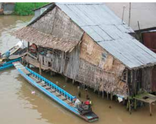
Abb. 1: Vulnerabilität ist immer abhängig von einer konkreten Gefahr. Die traditionellen Pfahlbauten im vietnamesischen Mekong-Delta sind aufgrund der verwendeten Materialien und der Bauweise an die häufig auftretenden Hochwasserereignisse angepasst. (Foto: Juergen Weichselgartner)
