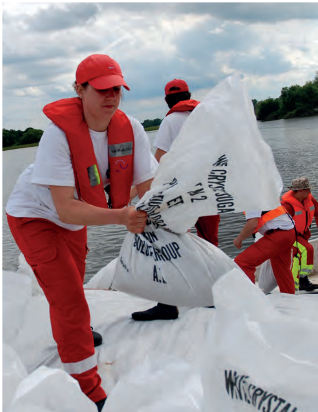
Befestigung der Uferböschung mit Sandsäcken. (Foto: DRK)
