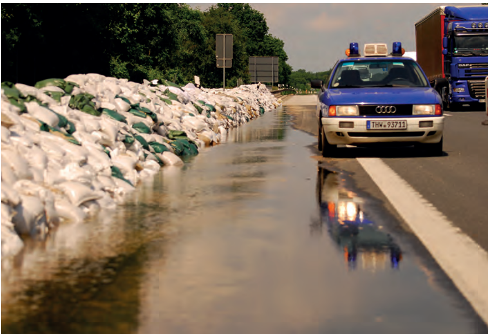
Wegen überfluteter Straßen war häufig schon die Anfahrt zum Einsatzort für die THW-Kräfte eine Herausforderung. (Fotos: THW)
