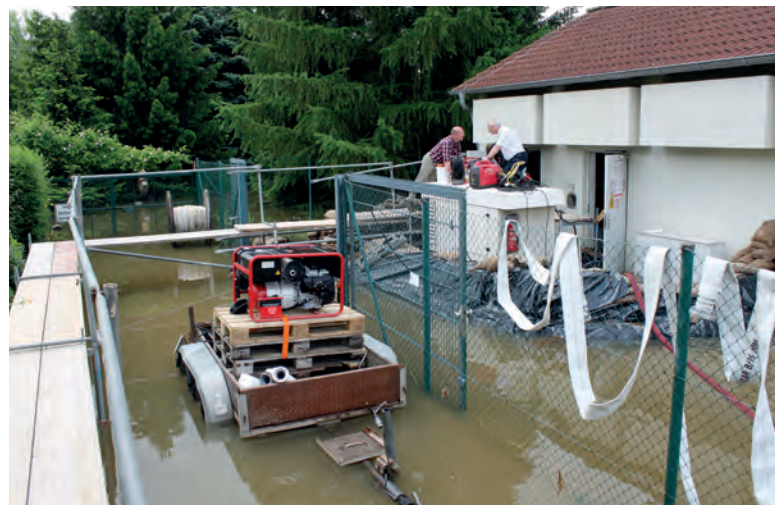
Betrieb eines Telefon-Hauptverteilers als Teil des Krisenmanagements. Die Abstimmung zwischen Betreiber und Verwaltung ist Aufgabe des Stabes. (Foto: Hubertus Kischkewitz / Deutsche Telekom AG)
