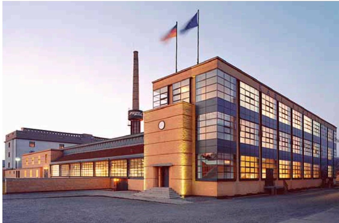
Das Hauptgebäude des Fagus-Werkes mit seinen revolutionären „offenen“ Gebäudeecken, die am Beginn der modernen Skelettbauweise stehen. (Foto: Carsten Janssen/cc-by-sa-2.0-de/wikipedia)
