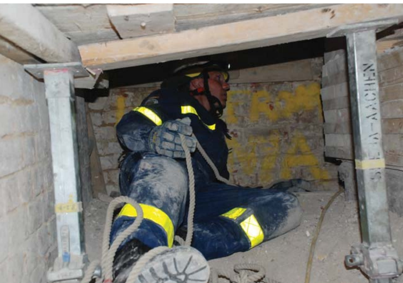
Enge Tunnelsysteme fordern das ganze Können der Rettungskräfte.
