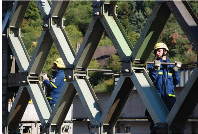
Rund 50 Tonnen Stahl sowie 1.500 Schrauben und Muttern verbanden die Helferinnen und Helfer jeder Fachgruppe Brückenbau.
