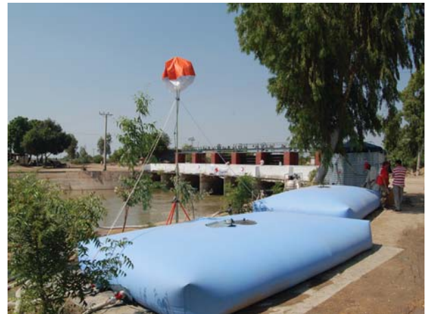
Trinkwasseraufbereitungsanlage. (Fotos: DRK)
