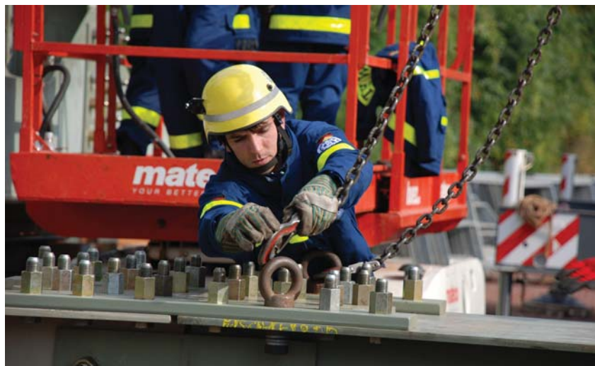
14 THW-Fachgruppen Brückenbau übten zwei Wochen in Konz den Aufbau von Eisenbahnbehelfsbrücken.
