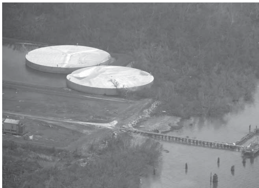
Versetzte und leckgeschlagene Oeltanks durch Wirbelsturm Katrina 2005. (Foto: Louisiana Department of Environmental Quality)
