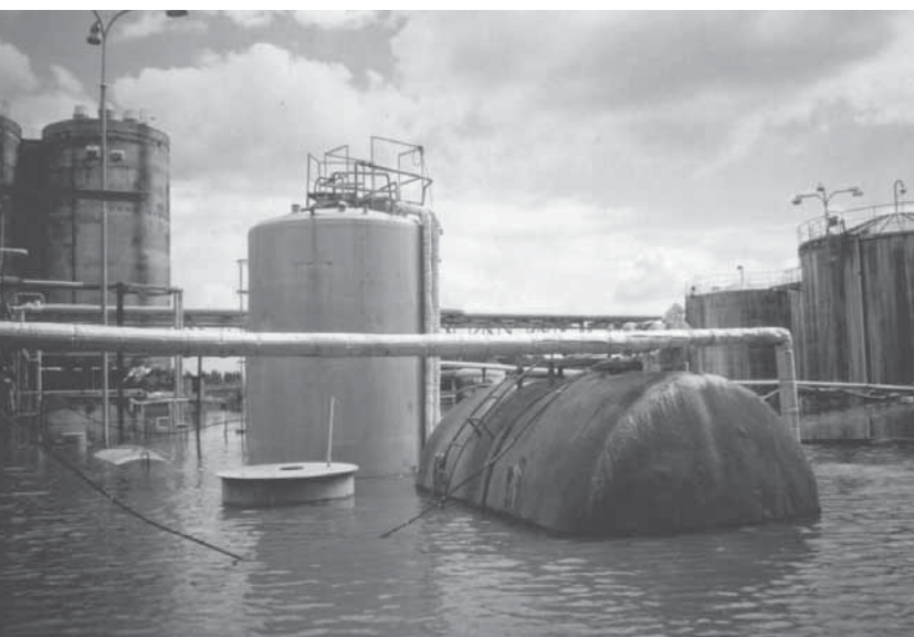
Überschwemmung einer Chemieranlage während des Elbe-Hochwassers im Sommer 2002. (Photo: Credit P. Danihelka)
