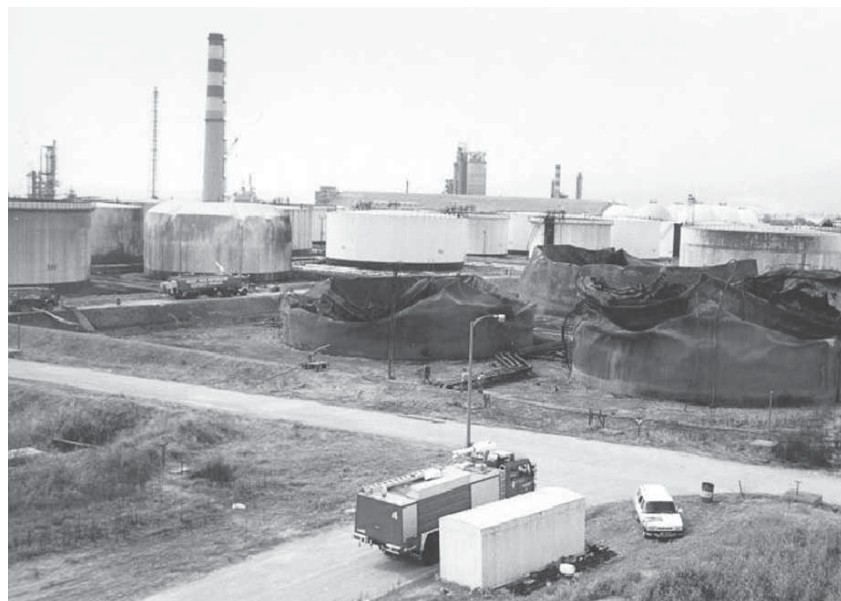
Ausgebrannte Tanks einer Oelraffinerie nach dem Kocaeli Erdbeben 1999.
