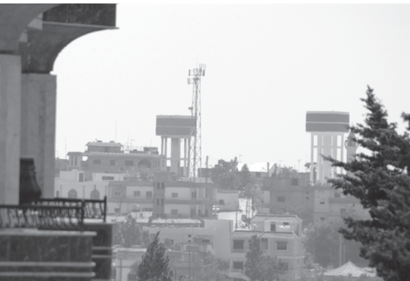
Für die Bevölkerung ist die Sicherstellung der Wasserversorgung ein Schritt zurück in die Normalität. (Fotos: THW)
