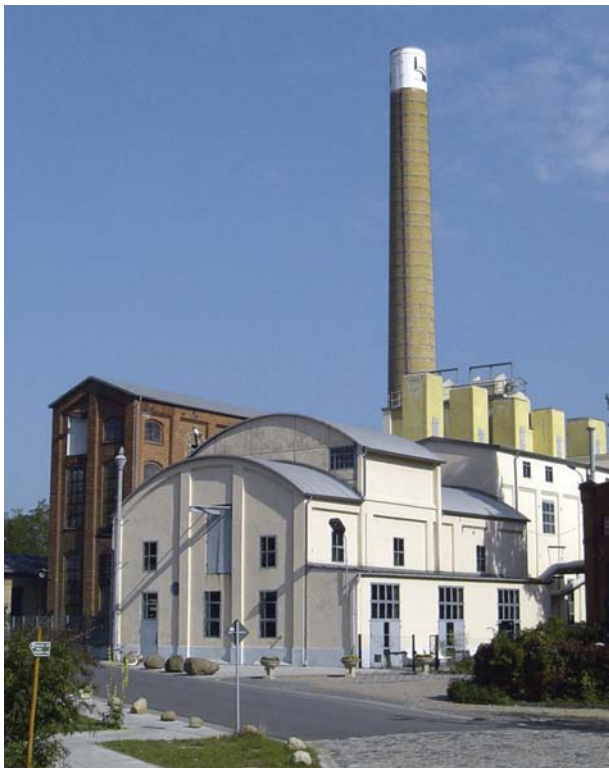
Westansicht der Anlage. Der Schornstein musste bei der Restaurierung um einige Meter gekürzt werden (Foto: Mechthild Passek).
