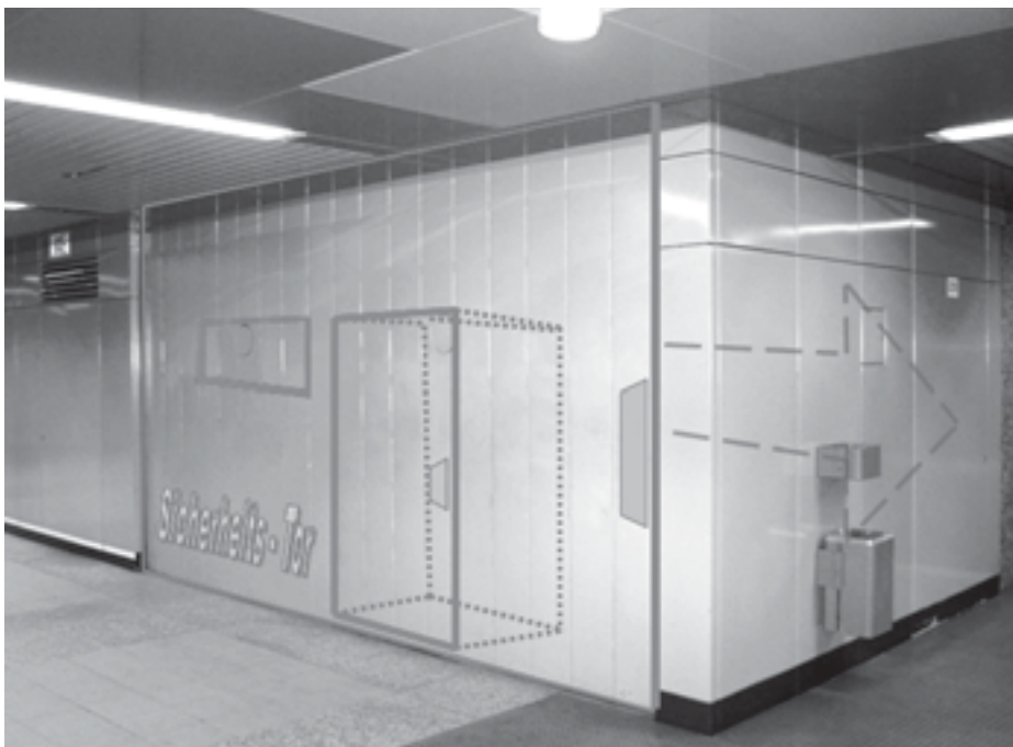
Anstelle des vorhandenen Schutzraumtors können schnell schließbare Stahlstore mit Schlupftür und flexiblen Schleusen für eine sofortige Inbetriebnahme eines Sicherheitsbereichs sorgen. Mit (verplombten) Einhandverschlüssen können sie von jedermann im Gefahrfall ohne Spezialwerkzeug schnell geschlossen werden (siehe übergelegte Graphik). (Bild und Graphik: Turley)
