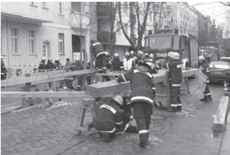
Etwa vier Stunden dauerte es, bis die Hilfskonstruktion zum Schutz der Einsatzkräfte zusammengebaut und in Position gebracht war. Das verwendete Material gehörte nicht zum Abstützsystem Holz (ASH) und war separat aus THW-Beständen anzufordern.
