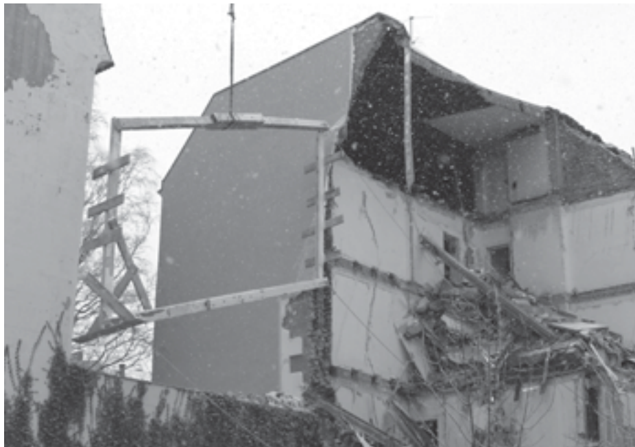
Die Hilfskonstruktion schwebte ein und wurde gesichert.
