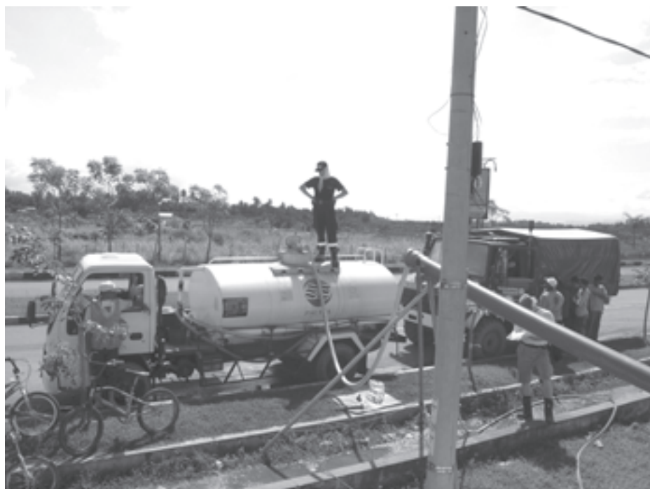
Nach der Aufbereitung wird das Wasser verteilt.
