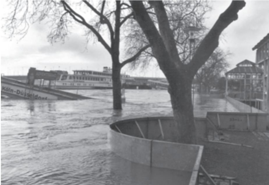
Der mobile Hochwasserdamm vermag die Kölner Altstadt nur bis zu einem Pegelstand von 10m zu schützen. (Fotos: Hochwasserschutzzentrale Köln)
