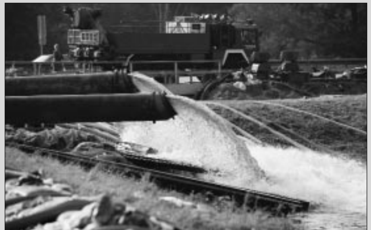
Die Pumpen hatten Schwerstarbeit zu leisten.
