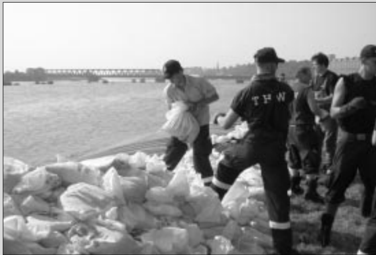
Deichsicherung war eine der wichtigsten Aufgaben der THW-Helfer.
