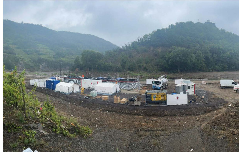
Zwei Mehrzweckraumzellen (MRZ) aus dem Bestand des Pilotprojektes „Labor Betreuung 5.000“ im Einsatz für die temporäre Kläranlage in Mayschoss. (Foto: Benjamin Sertl / DRK)
