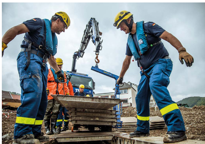
Mit vereinten Kräften geht der Wiederaufbau im Ahrtal voran. (Foto: THW / Nicole Endres)
