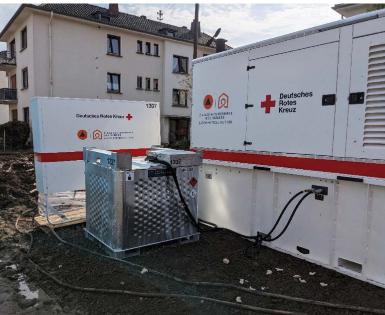
Ersatzstromerzeuger (ESE 300) mit einer Leistung von 300 kVA. Diese wurden während der Flutkatastrophe zur dezentralen Versorgung der Bevölkerung eingesetzt. (Foto: Machinia/BBK)
