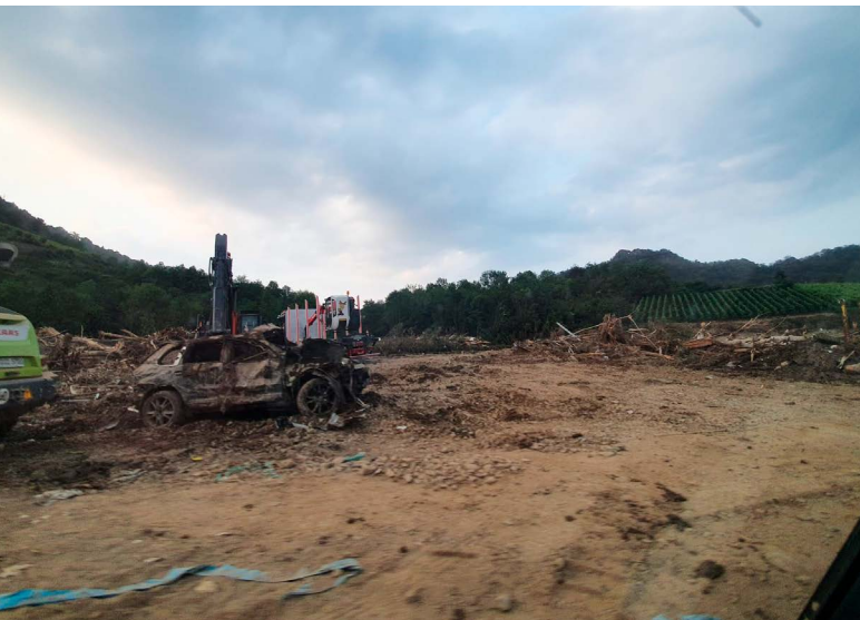
Großflächig zerstörte Infrastruktur nach der Flut im Ahrtal, Juli 2021. (Foto: B. Walkenbach/BBK)
