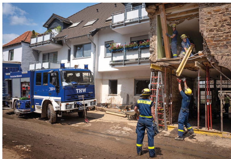
Zahlreiche beschädigte Häuser stützten THW-Einsatzkräfte im Rahmen der Gefahrenabwehr. (Foto: THW / Yann Walsdorf)
