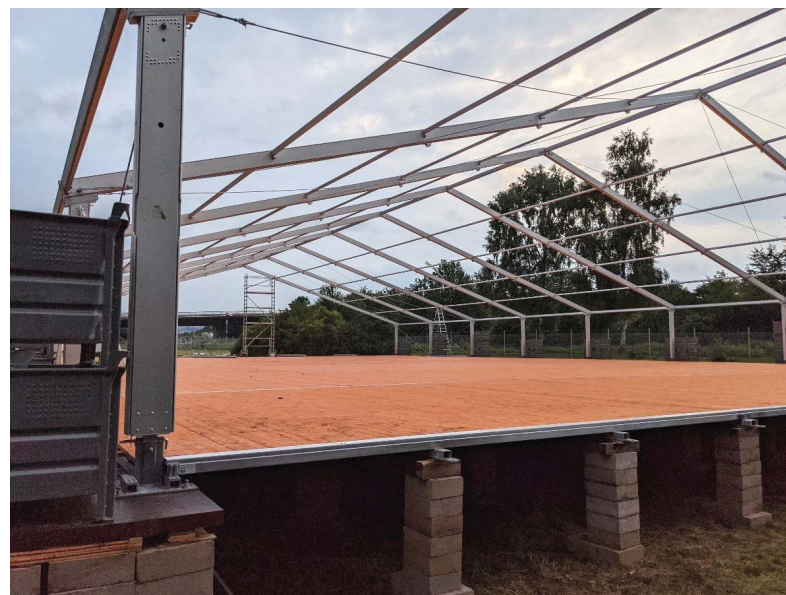
Aufbau Verpflegungszelt in Mendig. (Foto: Machinia / BBK)
