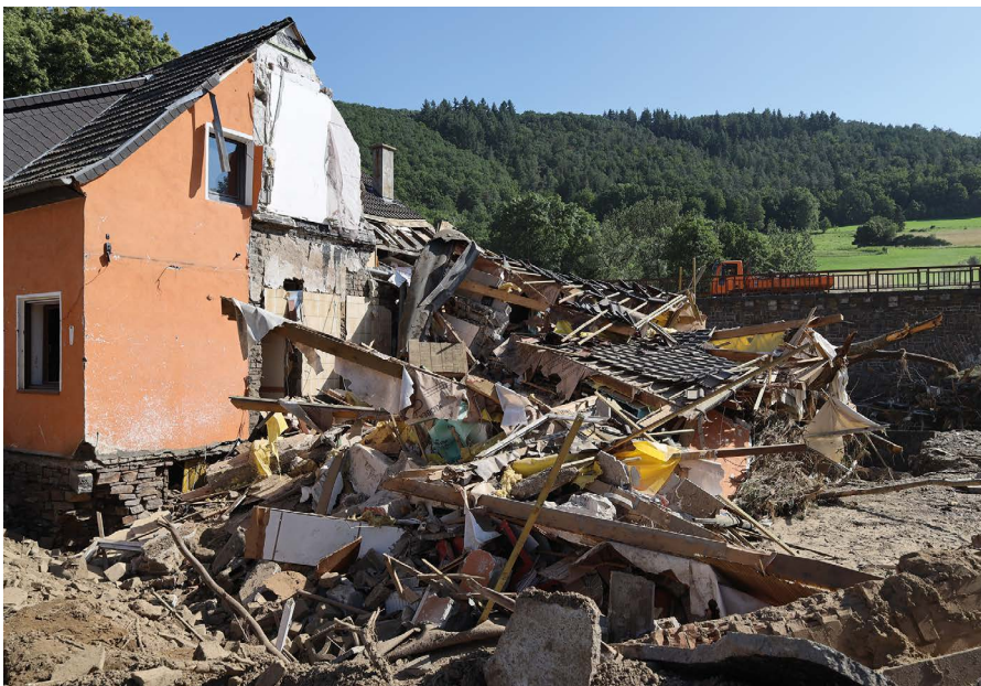
Bild der Zerstörung im Ort Schuld an der Ahr. (Foto: Benedikt Wolter, LFV Rheinland-Pfalz).
