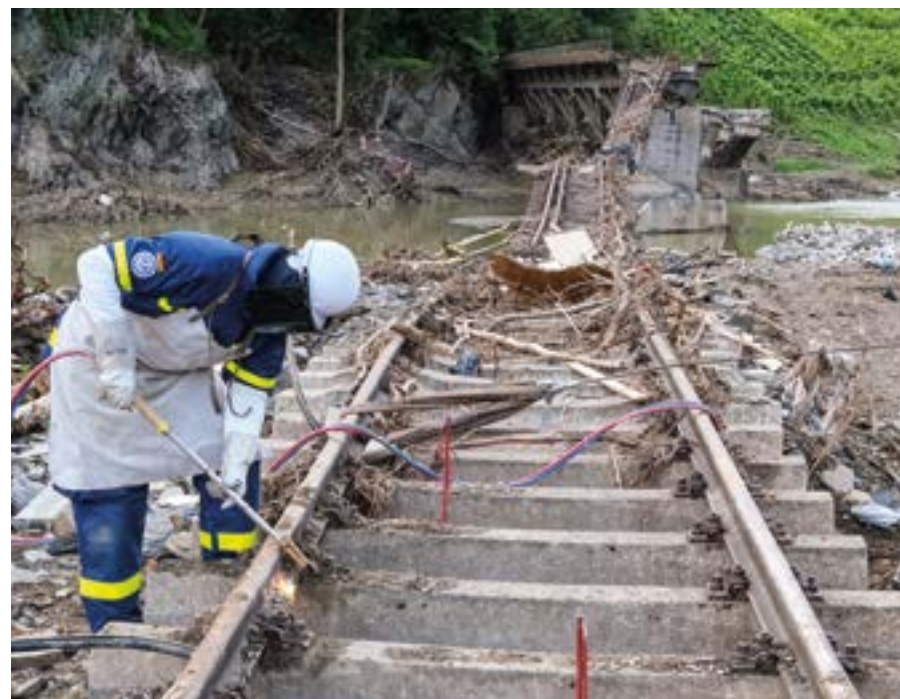
Gleisdemontage in Mayschoss. (Foto: Kai-Uwe Wärner)
