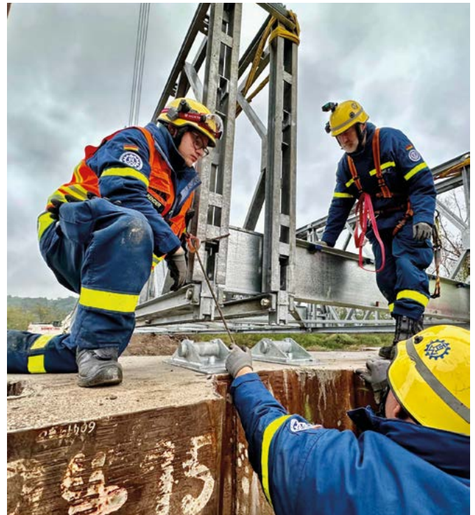
„Insgesamt 25 neue Brücken haben die Einsatzkräfte des THW nach der Flutkatastrophe errichtet.“ (Foto: THW / Michael Simrock)
