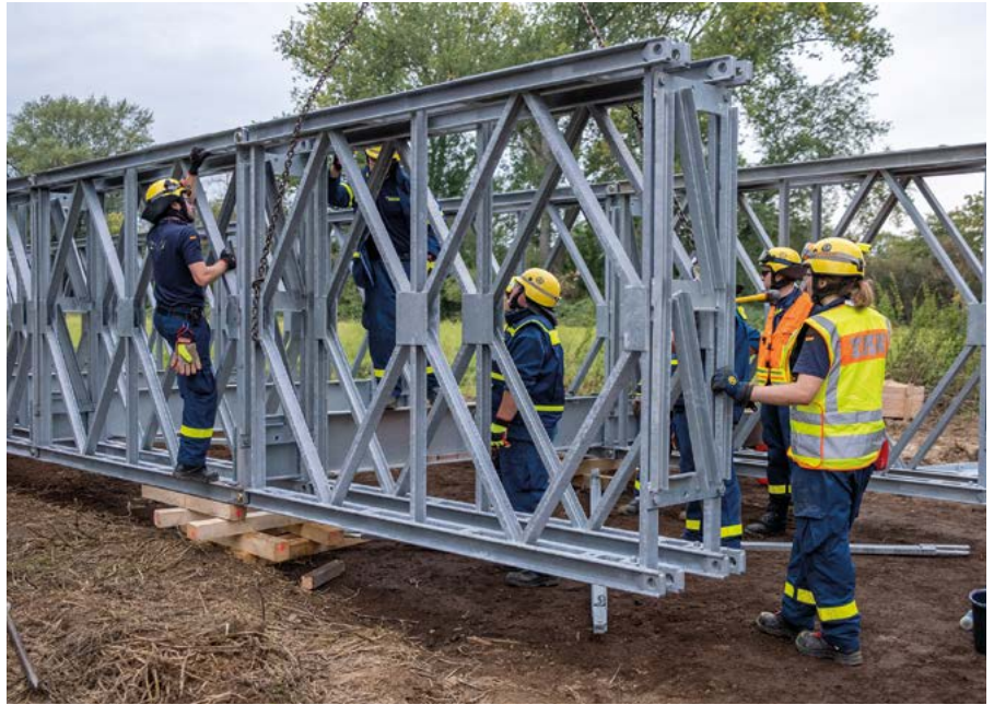
„Insgesamt 25 neue Brücken haben die Einsatzkräfte des THW nach der Flutkatastrophe errichtet. (Foto: THW/Robin Ramos-Hoffmann)“
