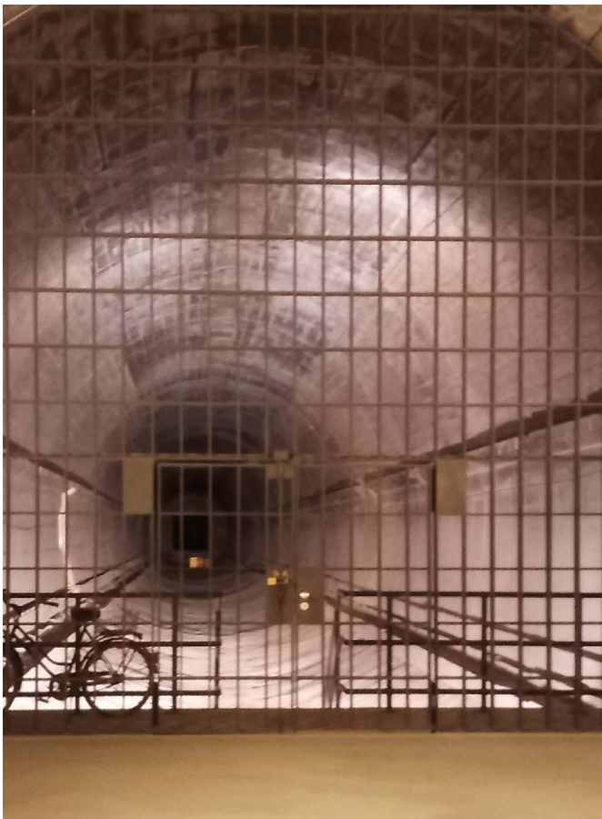
Blick in den rückgebauten und gesperrten Teil des Bunkers.
