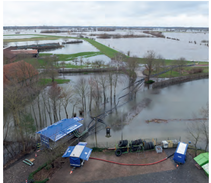
An den Einsatzstellen im Bereich des Serengeti-Parks in Niedersachsen setzten THW-Fachgruppen Hochleistungspumpen ein, die zusammen pro Minute 109.000 Liter Wasser abbumpfen. (Quelle: THW)
