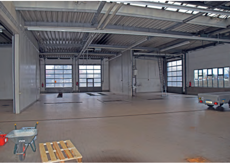
Fahrzeughalle beim Umbau. (Fotos: Johanniter / Martin Storch, Danilo Schulz, Sebastian Späthe)
