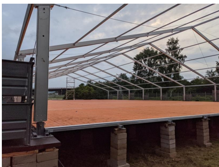
Aufbau Verpflegungszelt in Mendig Quelle: Machinia / BBK
