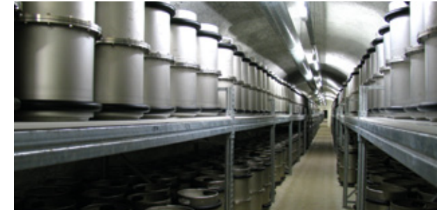
Regallager im Stollen.
